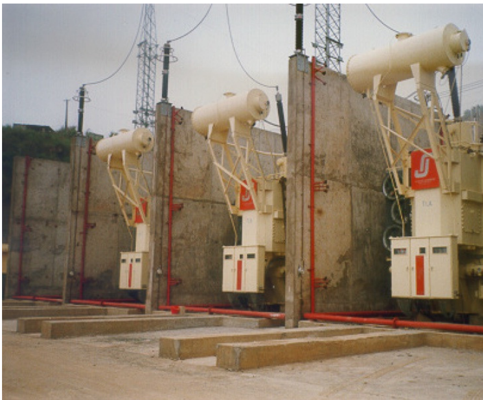
Figura 2: Banco de autotransformadores. Fonte: Eletronorte/Eletróbrás
